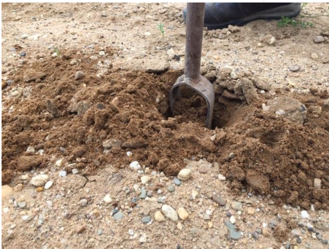
Foto 8. De hoogwatervluchtplaats is met grindhoudende grond afgewerkt en daarna aangedrukt.
