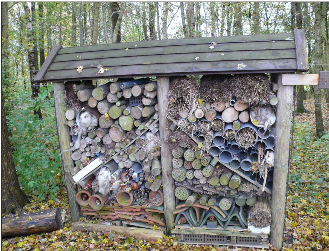
Figuur 12. Een vervallen, niet onderhouden bijenhoeven
